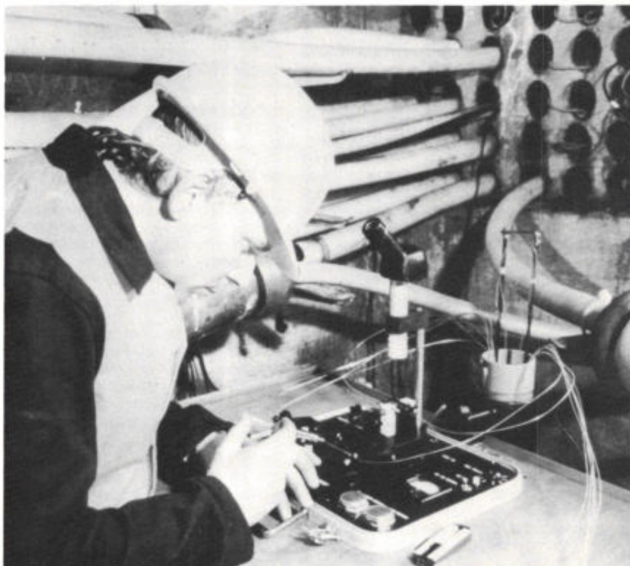
Ook onder moeilijke werkomstandigheden kunnen lassen in glasvezels worden gemaakt met behulp van speciale apparatuur. Met behulp van een microscoop kan de monteur de lasplaats bekijken. (foto ITT-STC)
